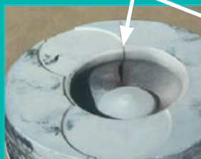
Crack initiation site
